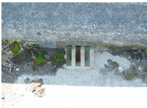
【排水ますの土砂詰まり清掃後】
