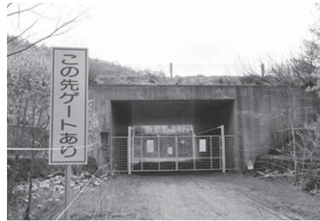
町道 17 号東線 高速道路下通行口
