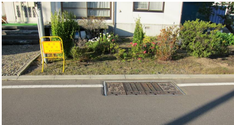
市街地内に設けられた融雪システムの投雪溝
