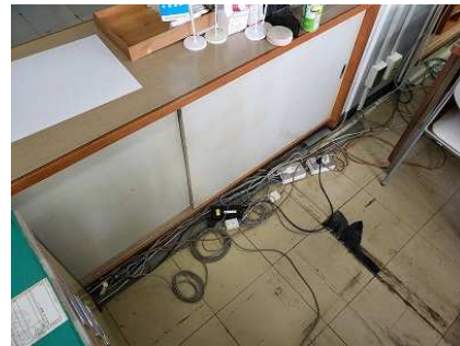
露出した配線
