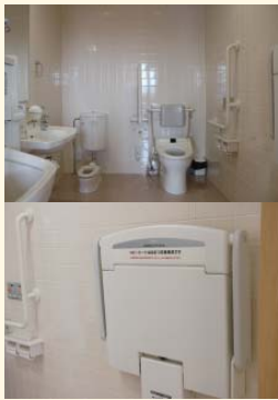
多目的トイレ(上) オムツ取替台(下)
