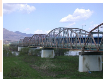
旧奈井江大橋
